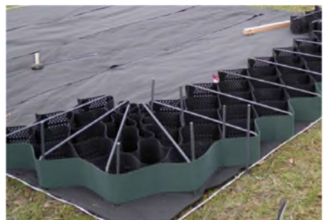
ジオセルの展開(曲線部)
