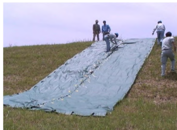
水防シートの展張状況
